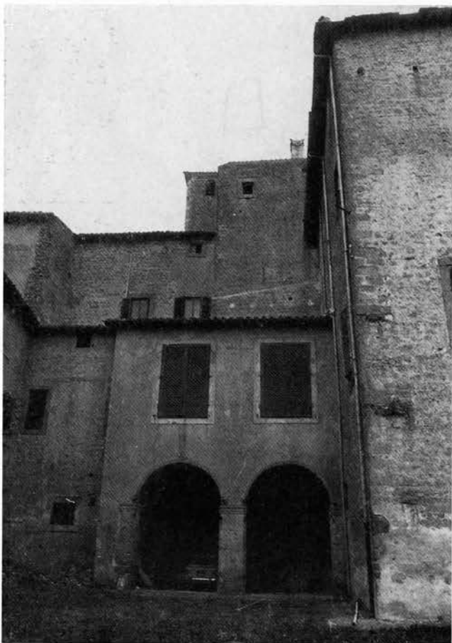
14 - ORIOLO ROMANO, PALAZZO ALTIERI - PARTICOLARE DEL PROSPETTO POSTERIORE: PORTICO
