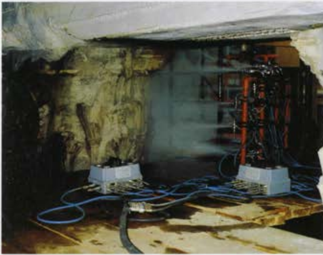
c) SISTEMA DI ATOMIZZAZIONE IN FUNZIONE SU UN CAPITELLO (foto Araldo de Luca)
