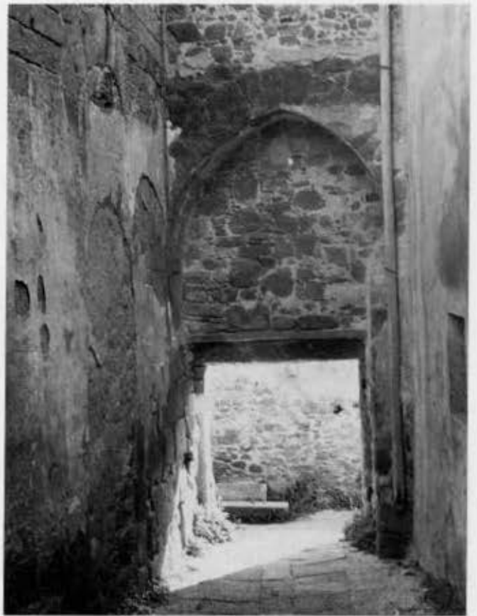
30 - ISOLA DEL GIGLIO, LOCALITÀ CASTELLO - ROCCA PISANA Sulla sinistra il portale d'ingresso della Chiesa tamponato per motivi statici, al centro la porta di accesso della piazza.
