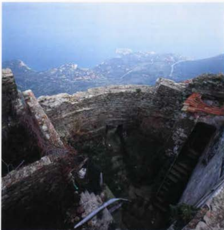
1 - ISOLA DEL GIGLIO, LOCALITÀ CASTELLO - ROCCA PISANA Il cortile interno alla base del mastio.
