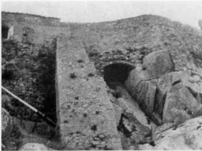
31 - ISOLA DEL GIGLIO, LOCALITÀ CASTELLO - ROCCA PISANA Veduta dall'esterno, al centro si nota la struttura a volta nata per sostituire l'antico ponte levatoio.
