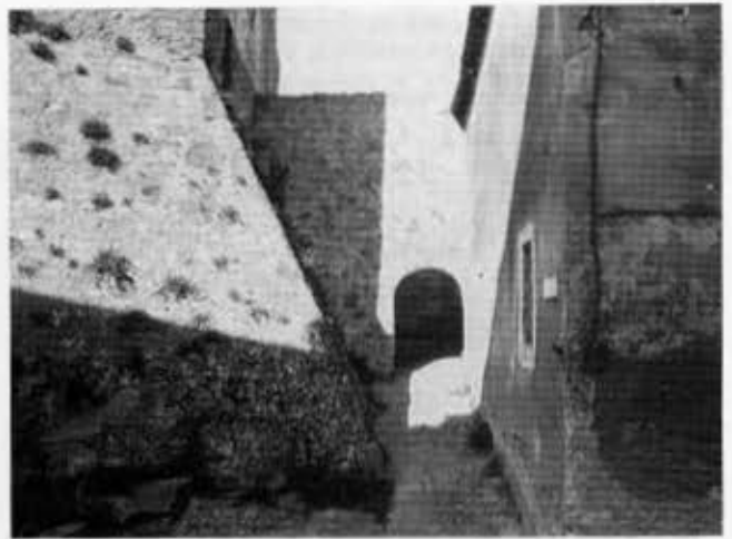
32 - ISOLA DEL GIGLIO, LOCALITÀ CASTELLO - ROCCA PISANA Sulla sinistra della foto la base del mastio, al centro il percorso interno che conduce al ponte levatoio.
