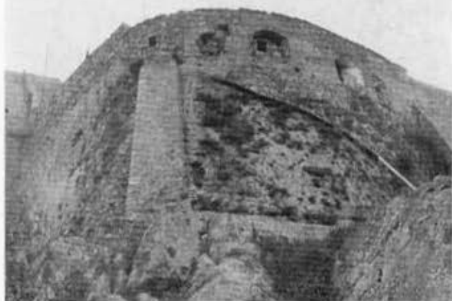
35 - ISOLA DEL GIGLIO, LOCALITÀ CASTELLO - ROCCA PISANA Veduta dall'esterno della cinta muraria, in alto si trovavano le postazioni delle batterie ed i mensoloni della bertesca ancora presente nel 1749, cfr. fig. 36.
