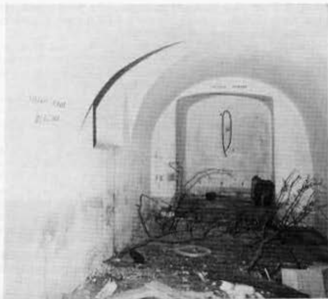
42 - ISOLA DEL GIGLIO, LOCALITÀ CASTELLO - ROCCA PISANA La casamatta vista dall'interno.
