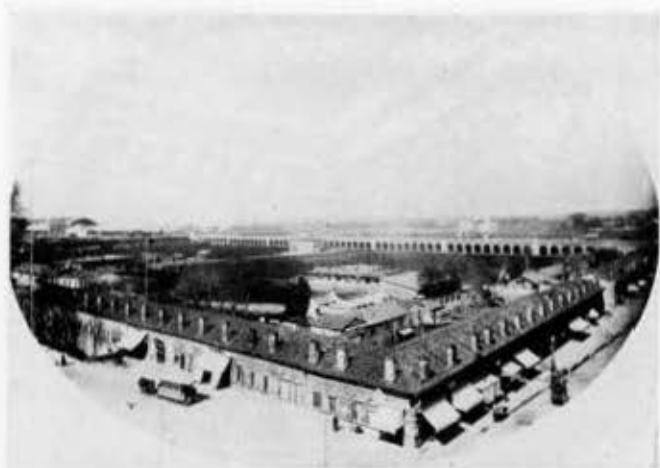
10 - MILANO, CASTELLO SFORZESCO ARCHIVIO FOTOGRAFICO DEL COMUNE VEDUTA GENERALE DEL LAZZARETTO CON IL VIADOTTO FERROVIARIO SULLO SFONDO (1880 CA.)
