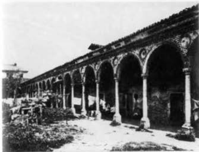
7 - MILANO, CASTELLO SFORZESCO ARCHIVIO FOTOGRAFICO DEL COMUNE, VEDUTA DI UN LATO DEL PORTICATO INTERNO DEL LAZZARETTO DI MILANO, (1880 CA.) Si noti la demolizione del muretto tra le colonne.
