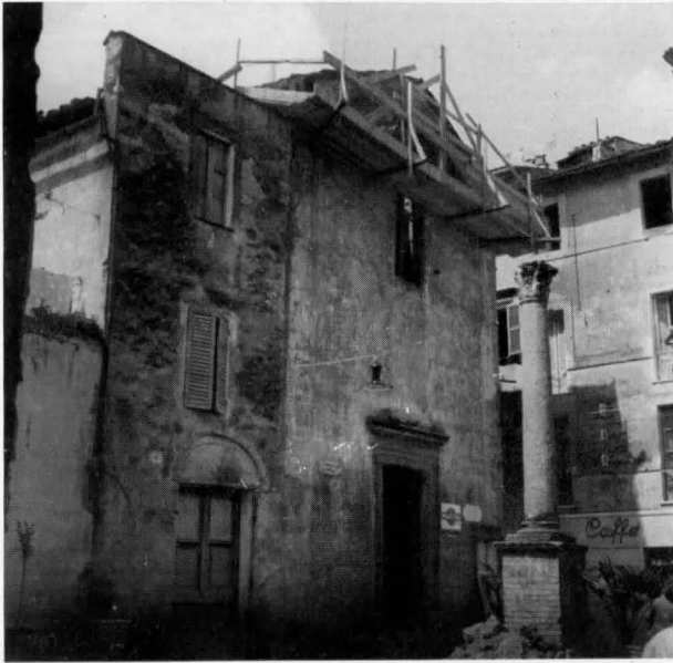
FIG. 1 - ORTE, S. SILVESTRO - IL PROSPETTO PRIMA DEL RESTAURO
