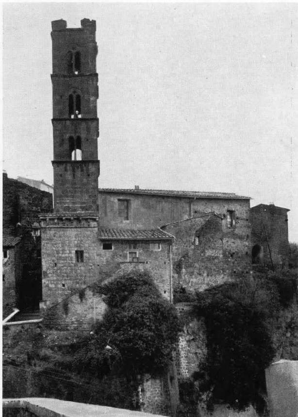
FIG. 8 - PROSPETTO DELLA PARETE SINISTRA, DOPO IL RESTAURO (Fot. Sopr. Mon. Lazio)
