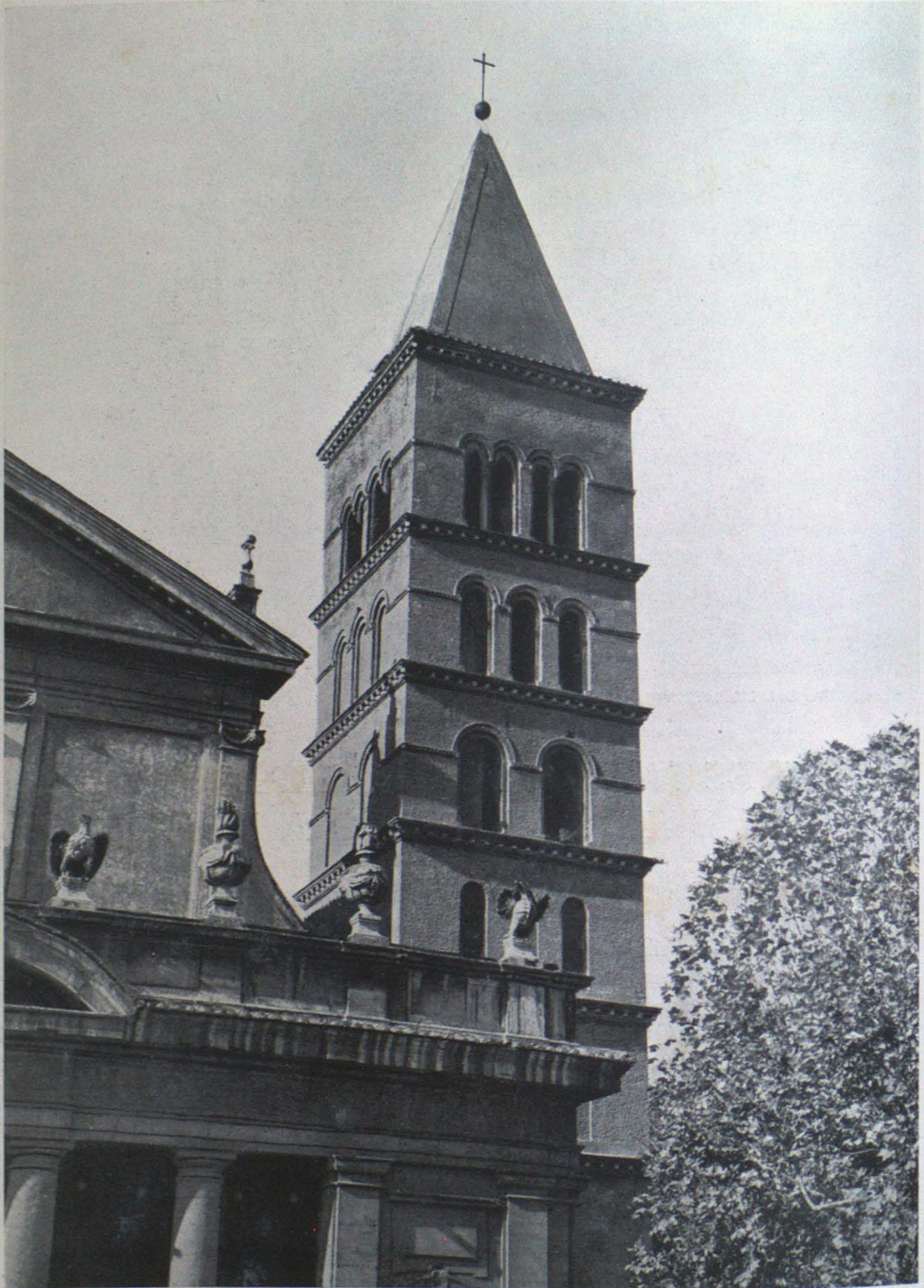
ROMA, CHIESA DI SAN CRISOGONO - CAMPANILE DOPO IL RESTAURO (Fot. R. Soprint. del Lazio)
