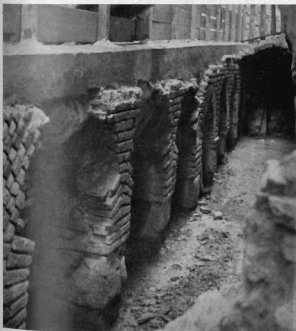
Fig. 2. Capitulum di Teate: gli archetti di sostegno alla scalèa.
