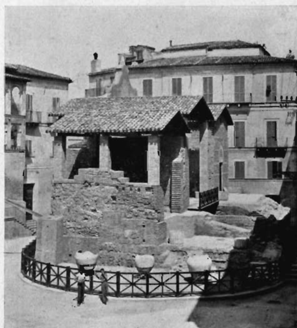
Fig. 3. Il Capitulum Teatinum a restauro compiuto.
