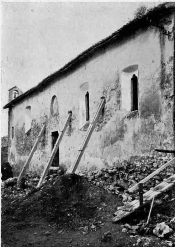
Fig. 11. SUBIACO: Chiesa della Madonna della Croce (durante i lavori di restauro).
