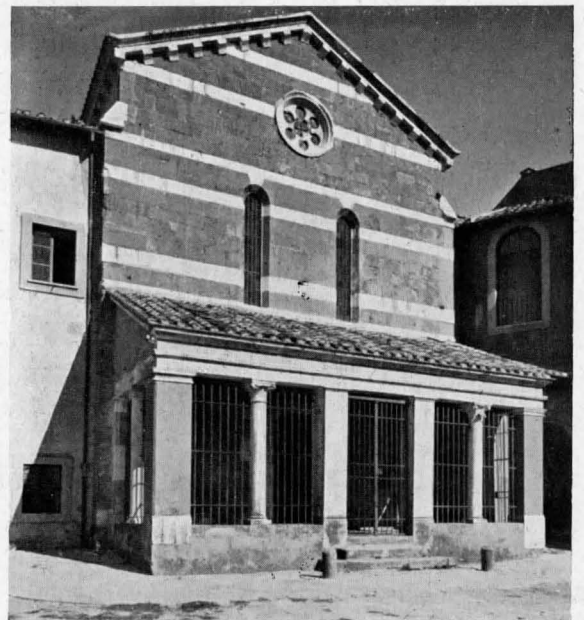
Fig. 12. PALAZZOLO: S. Maria della Neve (dopo il restauro).
