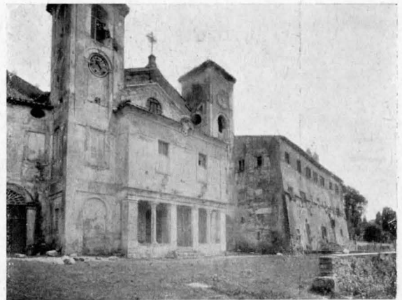
Fig. 10. PALAZZOLO: S. Maria della Neve (prima del restauro)
