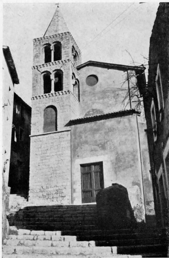
Fig. 18. SUBIACO: Chiesa di S. Pietro (dopo il restauro).
