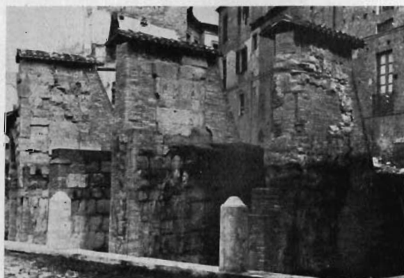
Fig. 6. TERAMO: Teatro romano. Restauri e protezione ai ruderi scoperti.
