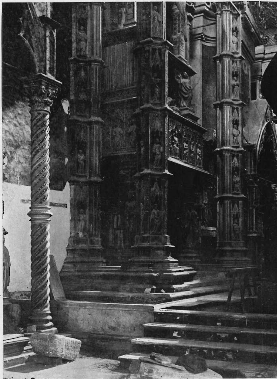
Fig. 4. — Sepolcro di Re Roberto — Stato attuale dopo l'isolamento.
